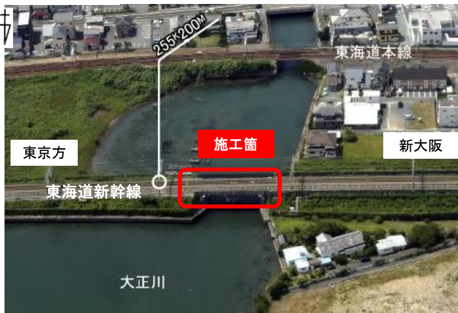
【施工位置写真】
