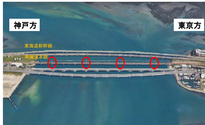
【第3浜名橋梁上足場設置箇所】
